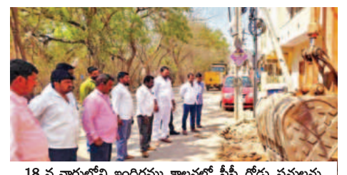
సినీ రోడ్డు పనులను పరిశీలించిన సురేష్ గౌడ్
