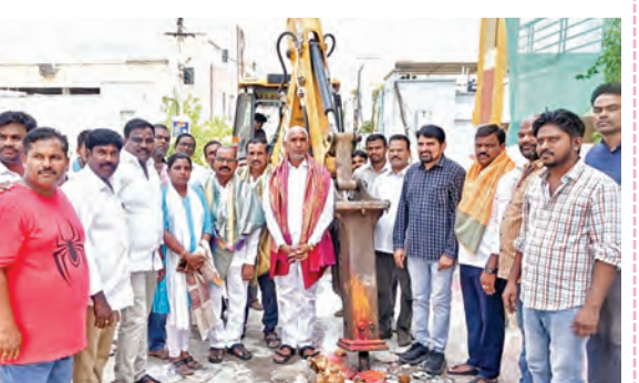
ఫైవలైన్ పనులను ప్రారంభిస్తున్న మాజీ మున్సిపల్ చైర్మన్
