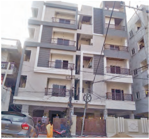
బాలనగర్ లో వెలసిన ఆక్రమ నిర్మాణం
