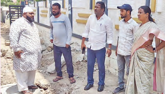
డ్రైనేజీ పనులను పరిశీలిస్తున్న మాజీ చైరెవర్సన్ పాపసయ్యాదవ్
