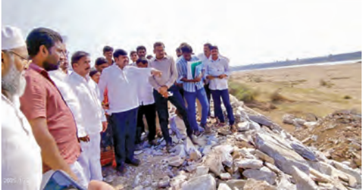
ముక్త్యాల-మాదిపాడు మధ్య కృష్ణానదిపై నిర్మిస్తున్న రైడ్జి పనులను పరిశీలిస్తున్న జగ్గయ్యపేట ఎంఎల్ఏ శ్రీరాం రాజగోపాల్, పెదకూరపాడు ఎంఎల్ఏ భాష్యం ప్రసీద్.
