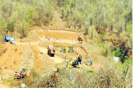
నల్లమల అడవులో జరుగుతున్న గుంటూరు-గుంతకల్లు డబుల్ రైన్ రైలు మార్గం సారంగాల పనులు
