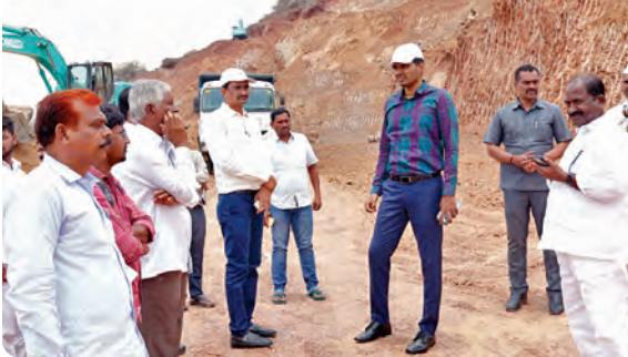
భూమి చదును పనులను పరిశీలిస్తున్న కలెక్టర్ మిక్కిలినేని మనుచౌదరి
