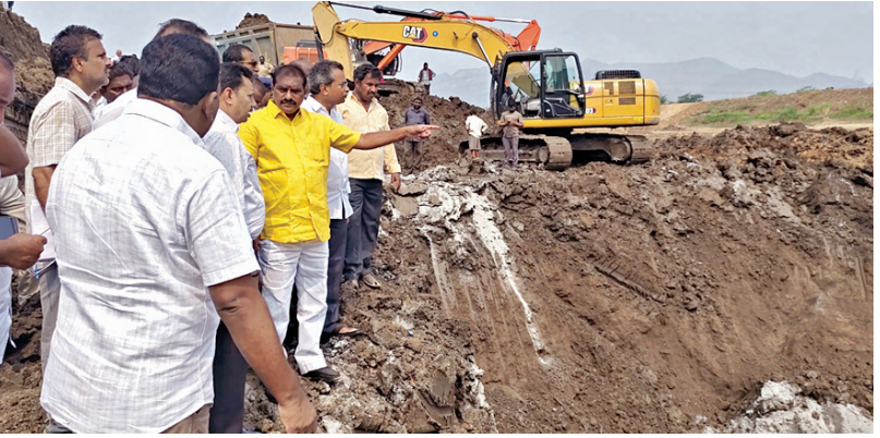
బుడవారం బుడమేరు నిర్మాణ పనులు పరిశీలిస్తున్న మంత్రి నిమ్మల తదితరులు
