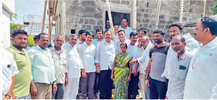
ఇళ్ల నిర్మాణం పనులను పరిశీలిస్తున్న రాంమోహన్రెడ్డి
