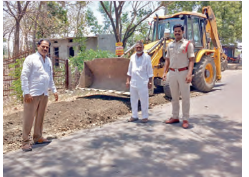
రోడ్డు పనులను చేయిస్తున్న తహసీల్దార్, ఎస్‌ఐ
