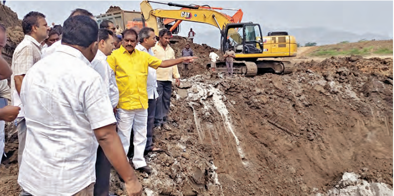
బుధవారం బుడమేరు నిర్మాణ పనులు పరిశీలిస్తున్న మంత్రి నిమ్మల తదివరలు
