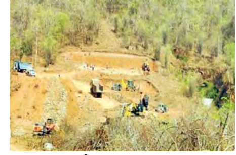
నల్లమల అడవుల్లో జరుగుతున్న గుంటూరు-గుంతకల్లు డబుల్ రైల్ రైలు మార్గం సారంగాల పనులు
