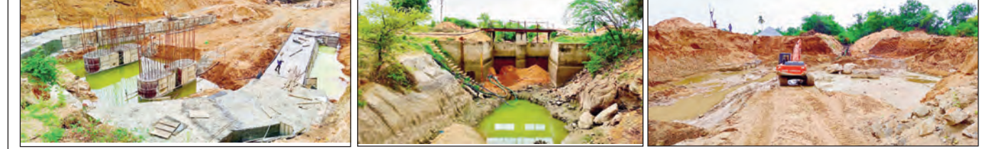
మోపిడి గ్రామంపై ఎంపీఆర్ రెగ్యులేటర్ పనులు జరుగుతున్న దృశ్యం..ఎంపీఆర్ పాత రెగ్యులేటర్ దృశ్యం, పీపీలైన్ రెగ్యులేటర్ పునః నిర్మాణ పనులు ఆగిపోయిన దృశ్యం
