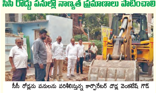
సీస రోడ్డు పనులను పరిశీలిస్తున్న కార్పొరేటర్ డౌడ్ వెంకటేశ్ గౌడ్
