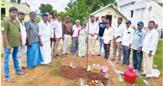
కొండేరులో ఇందిరమ్మ ఇంటి నిర్మాణానికి మార్క్
