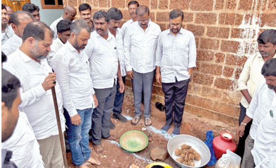
జూడిమలూపూర్‌లో జడ్ల నిర్మాణానికి భూమి పూజ చేస్తున్న గిరిధర్‌రెడ్డి
