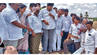
హంద్రీనీవా లైనింగ్ పనులను పరిశీలిస్తున్న రాష్ట్ర మాజీ ఎమ్మెల్యే తోపుదుర్తి ప్రకాష్ రెడ్డి
