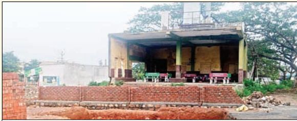
నిర్మాణంలో ఉన్న బంకు
