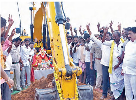
భైరవని తిప్ప ప్రాజెక్టు పనులు పున ప్రారంభ దృశ్యము
