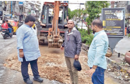
భారీ వర్షాల కారణంగా కుంగిపోయిన బండ్లగూడ జాగీర్ కార్పొరేషన్ పరిధిలోని సనోటి ప్రధాన రోడ్డుకు మరమ్మత్తులు చేయిస్తున్న మాజీ డిప్యూటీ మేయర్ పి.రాజేందర్రెడ్డి
