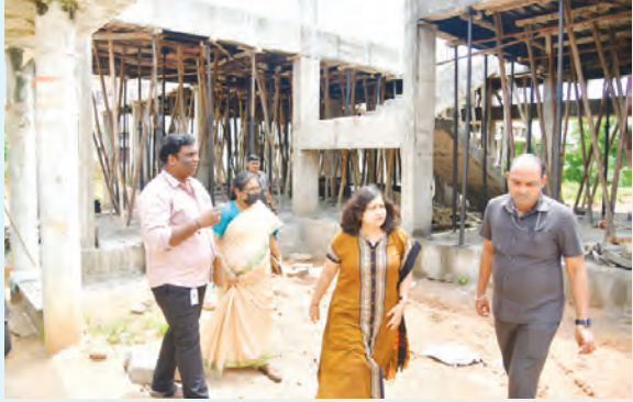
భవన నిర్మాణ పనులను పరిశీలిస్తున్న కలెక్టర్ విజయేంద్ర బోయి
