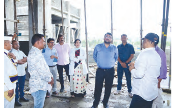
క్రిటికల్ కేరీ సెంటర్ పనులను పరిశీలిస్తున్న జిల్లా కలెక్టర్
