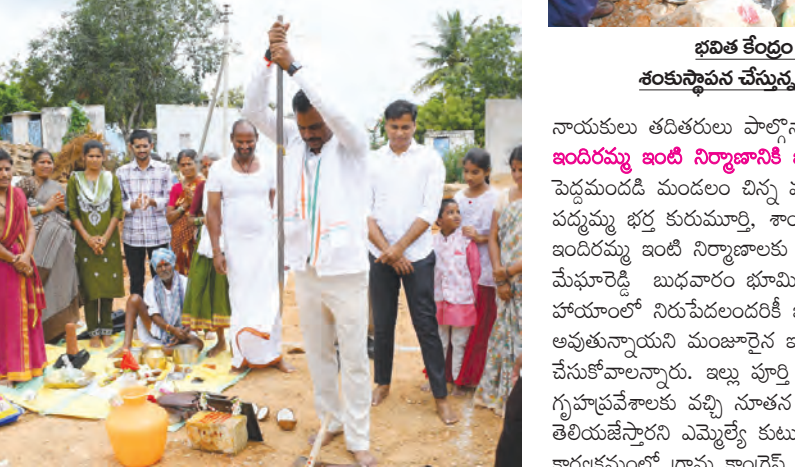
ఇందిరమ్మ ఇంటి నిర్మాణానికి భూమి పూజ చేస్తున్న ఎమ్మెల్యే
