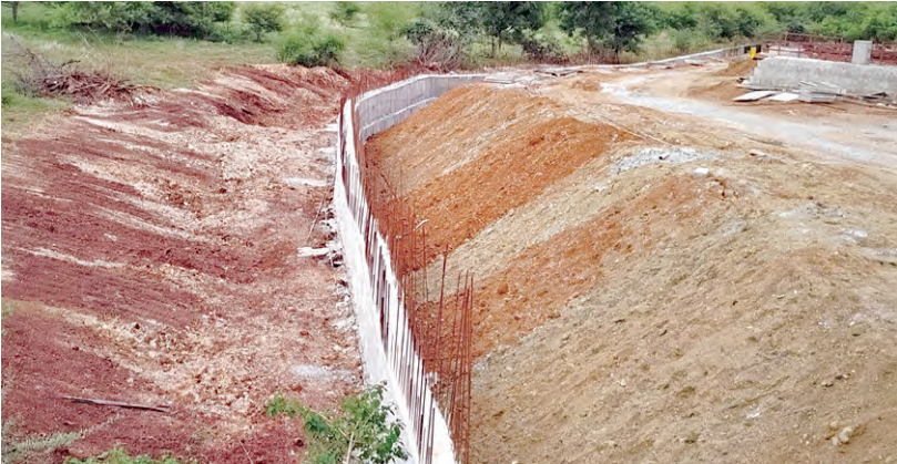
వెంచర్కు ప్రహరీగోడ నిర్మాణం చేపడుతున్న దృశ్యం
