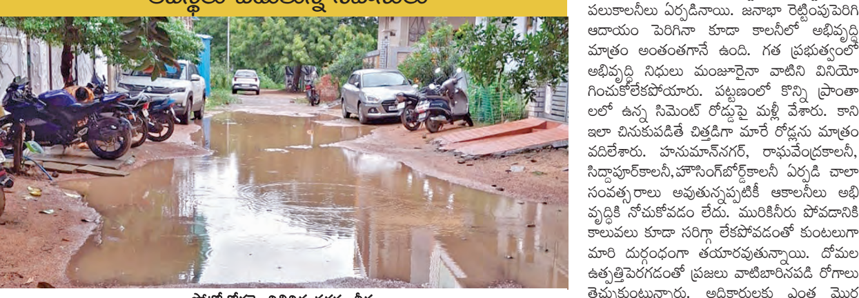
ఫోటో:రోడ్డు నిలదిన వర్షపు నీరు
