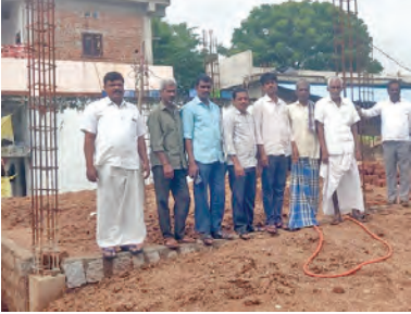
ఇందిరమ్మ ఇంటి నిర్మాణ పనులు పరిశీలిస్తున్న నాయకులు
