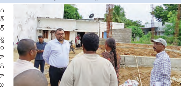
ఇందిరమ్మ ఇంటి నిర్మాణాన్ని పరిశీలిస్తున్న కలెక్టర్
