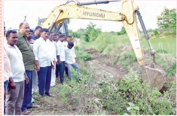
కుడికాలువ మరమ్మత్తు పనులను పరిశీలిస్తున్న ఎమ్మెల్యే నంజీరెడ్డి
