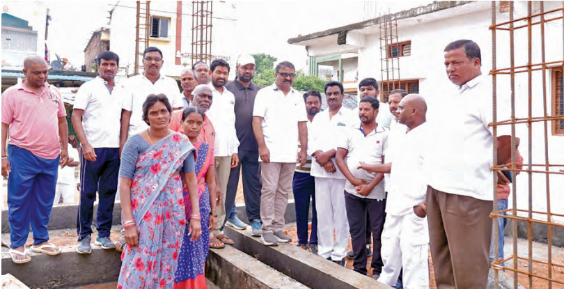
ఇందిరమ్మ ఇల్ల నిర్మాణ పనులను పరిశీలిస్తున్న ఆవుల రాజీరెడ్డి, మచునూరి రాజుయాదవ్
