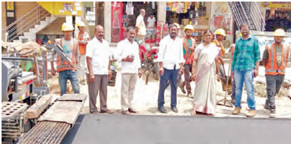
రోడ్డు పనులను పరిశీలిస్తున్న మున్సిపల్ మాజీ చైర్మవర్గన్ పాపని జంగయ్యయాదవ్
