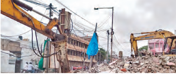
పాతనగరంలో మెట్రో నిర్మాణం కోసం రోడ్డు విస్తరణ పనులను చేపడుతున్న దృశ్యం
