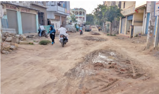
మేడ్చల్ పట్టణంలోని హౌసింగ్ బోర్డ్ కాలనీ నుండి రైల్వే స్టేషన్ రోడ్డులో డ్రైనేజీ నిర్మాణం పరిధివేయడం వల్ల ఏర్పడిన గుంతలు
