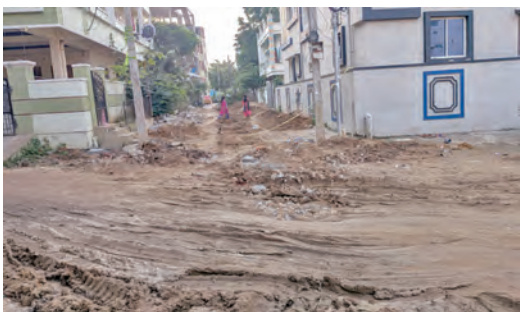
మేడ్చల్లో పనులు నడుస్తున్న రైల్వే స్టేషన్ రోడ్డుకు అనుగుణంగా ఉన్న పక్క రోడ్డులో సత్నడకన నడుస్తున్న డ్రైనేజీ పనులు
