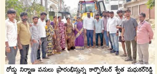
రోడ్ల నిర్మాణ వనులు ప్రారంభిస్తున్న కార్పొరేటర్ శ్వేత మనకరిరెడ్డి
