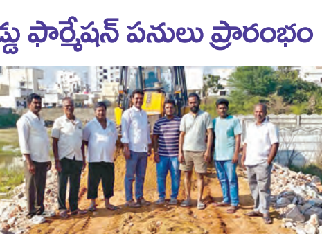
అల్వాన్గూడ విశాఖనగర్‌లో రోడ్డు ఫార్వేషన్ పనులను కాలనీవాసులతో కలిసి పరిశీలిస్తున్న కాంగ్రెస్ నాయకుడు నవారు మల్లారెడ్డి
