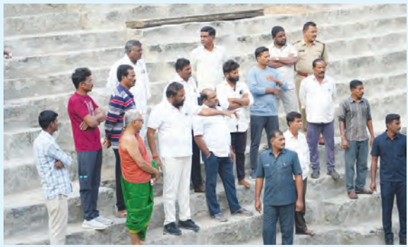
కోనేరు పునర్నిర్మాణ పనులు పరిశీలిస్తున్న మంత్రి
