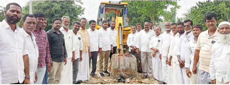
మట్టి రోడ్డుపనులు ప్రారంభిస్తున్న దృశ్యం
