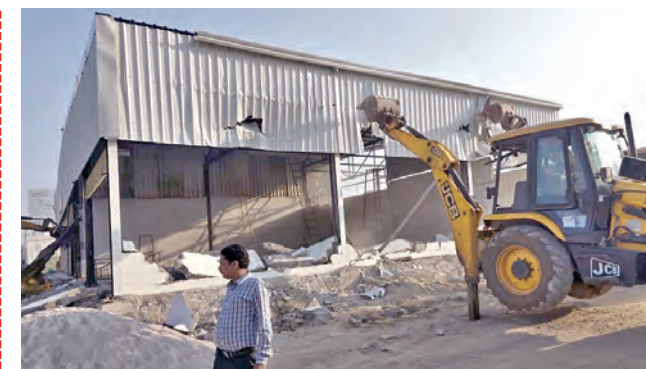
ఆక్రమ నిర్మాణాలను తొలగిస్తున్న అధికారులు
