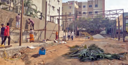
నిర్మాణంలో ఉన్న అక్రమ షెడ్డు
