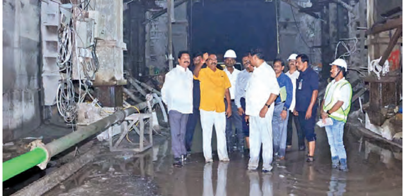
వెలిగొండ ప్రాజెక్టు టన్నెల్ లోపల పనులను పరిశీలిస్తున్న మంత్రి నిమ్మల రామానాయుడు
