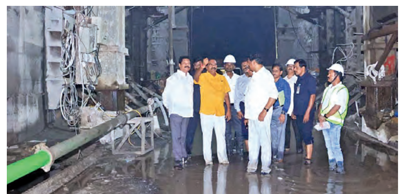
వెలిగొండ ప్రాజెక్టు టెస్ట్ లోపల పనులను పరిశీలిస్తున్న మంత్రి నిమ్మల రామనాయుడు
