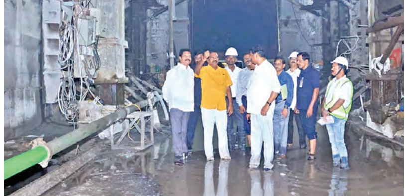
వెలిగొండ ప్రాజెక్టు టన్నెల్ లో పనులను పరిశీలిస్తున్న మంత్రి నిమ్మల రామానాయుడు
