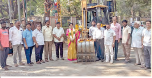
రోడ్డు నిర్మాణం పనులను ప్రారంభిస్తున్న కార్పొరేటర్ బొక్క భాగ్యలక్ష్మి
