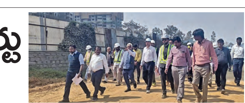
రాజేంద్రనగర్లో బుధవారం హైకోర్టు నిర్మాణ పనులను పరిశీలిస్తున్న అధికారులు
