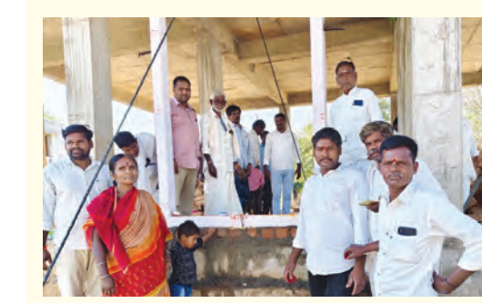
గ్రామ పంచాయతీ భవన నిర్మాణ పనులను ప్రారంభిస్తున్న దృశ్యం
