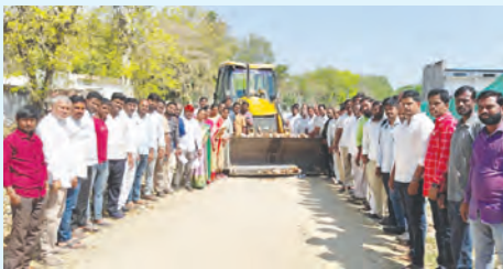
మిషన్ భగీరథ ఫైవ్ లైన్ పనులను ప్రారంభించిన మున్సిపల్ చైర్ పర్సన్ వాకిటి మానస హనుమంతు
