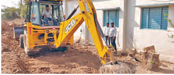
జడ్పీపాచ్ ఎన్ కు ప్రహారీ గోడ నిర్మాణం పనుల దృశ్యం
