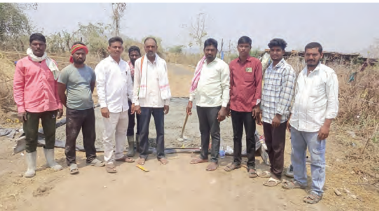
సీసీ రోడ్డు పనులు ప్రారంభించిన సర్పంచ్ మోహన్
