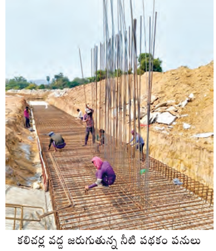
కలిచర్ల వద్ద జరుగుతున్న నీటి వర్షం పనులు
