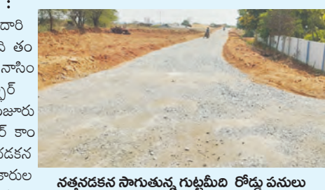
నత్వనడకన సాగుతున్న గుట్టమీది రోడ్డు పనులు
