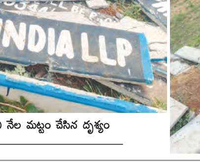
నిర్మాణాలను తొలగించి నేల మట్టం చేసిన దృశ్యం
