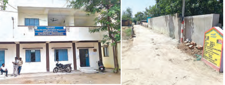
మండల కార్యాలయాల సముదాయంలో నూతన ఐసీడీయస్ భవనం, గ్రామీణ రోడ్డు నిర్మాణం
